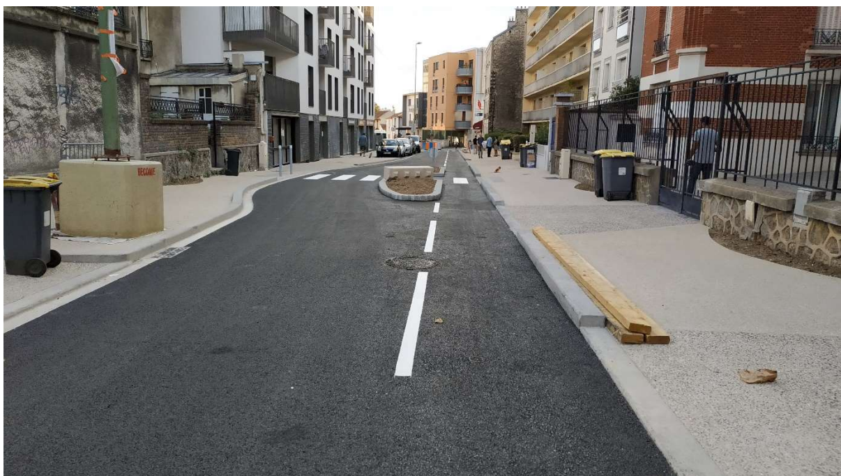
Figure 25 : Double sens cyclable avec marquage (attention marquage T3 5u nécessaire)
